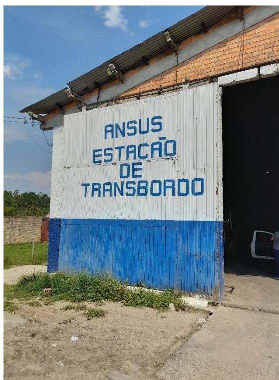
Figura 47: Portão de entrada da estação de transbordo da Ansus.
