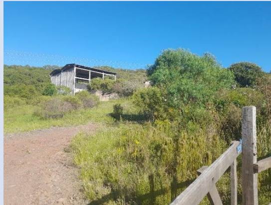
Figura 68: Prédio propriedade da Prefeitura utilizado atualmente para armazenamento de pneus.
